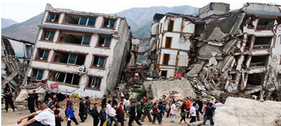
Рис. 2. Вид наклонившихся зданий в результате неравномерной сейсмопросадки основания в процессе землетрясения в Катманду (Непал, 2015 г.)
