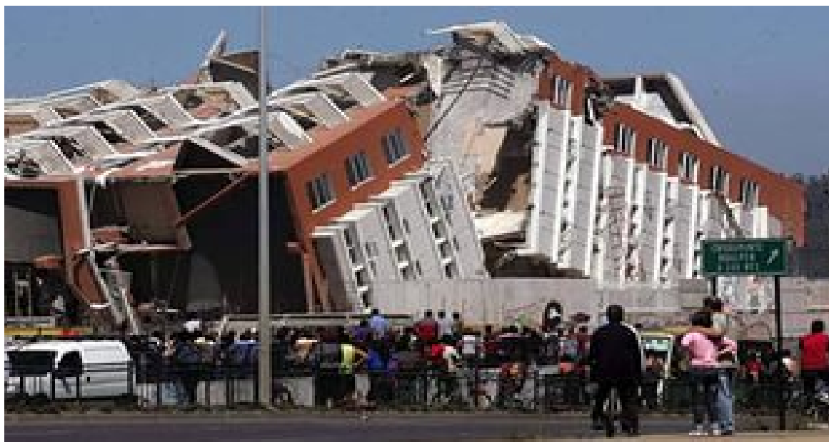
Рис. 4. Повреждения строений, характерные в условиях неравномерной сейсмопросадки грунта оснований при сильных землетрясениях (Чили, 2010 г.)
