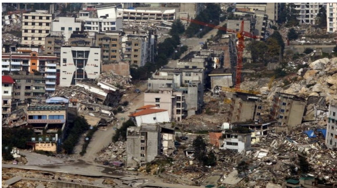
Рис. 1. Последствия землетрясения в провинции Сычуань (Китай) (многочисленные наклоны и оседания зданий были связаны с сейсмопросадочными деформациями грунта во время землетрясения)
